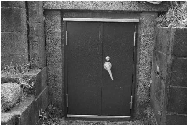
写真3 大日山35号墳石室扉設置状況
