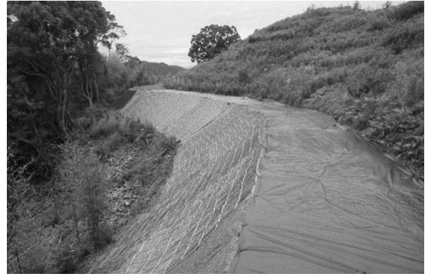
写真2 墳丘外北側の盛土、のり面成形
